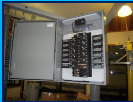
ENERGY GUARD ACOPLADO A TRANSFORMADOR DE DISTRIBUCION
