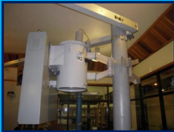
ENERGY GUARD ACOPLADO A TRANSFORMADOR DE DISTRIBUCION
