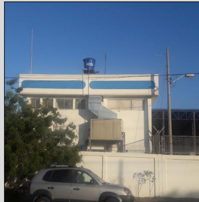
ANTENA RF. EN EDIFICIO CNEL
